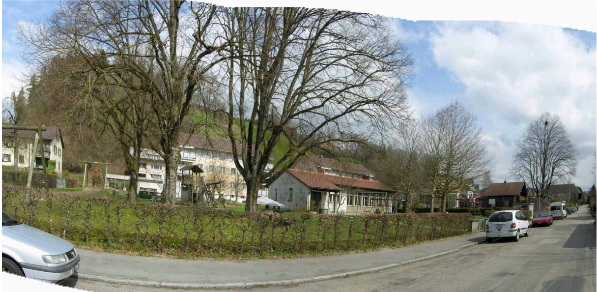
Bild 1: Panorama der Mooseeggstrasse in Langnau i.E. mit dem abzureissenden ehemaligen Kindergartengebäude. (Foto: Thomas Kaufmann, werk.Architekten)
