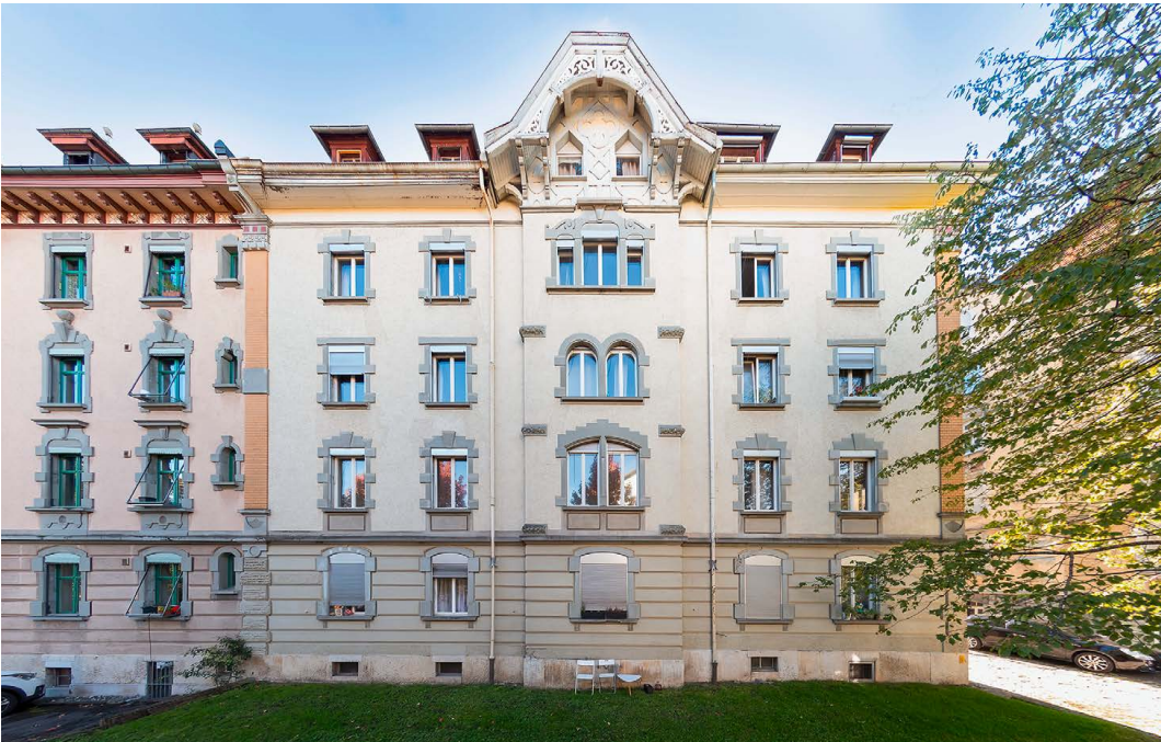
Wohnbaugenossenschaft St. Gallen, Zylistrasse, Saint-Gall
